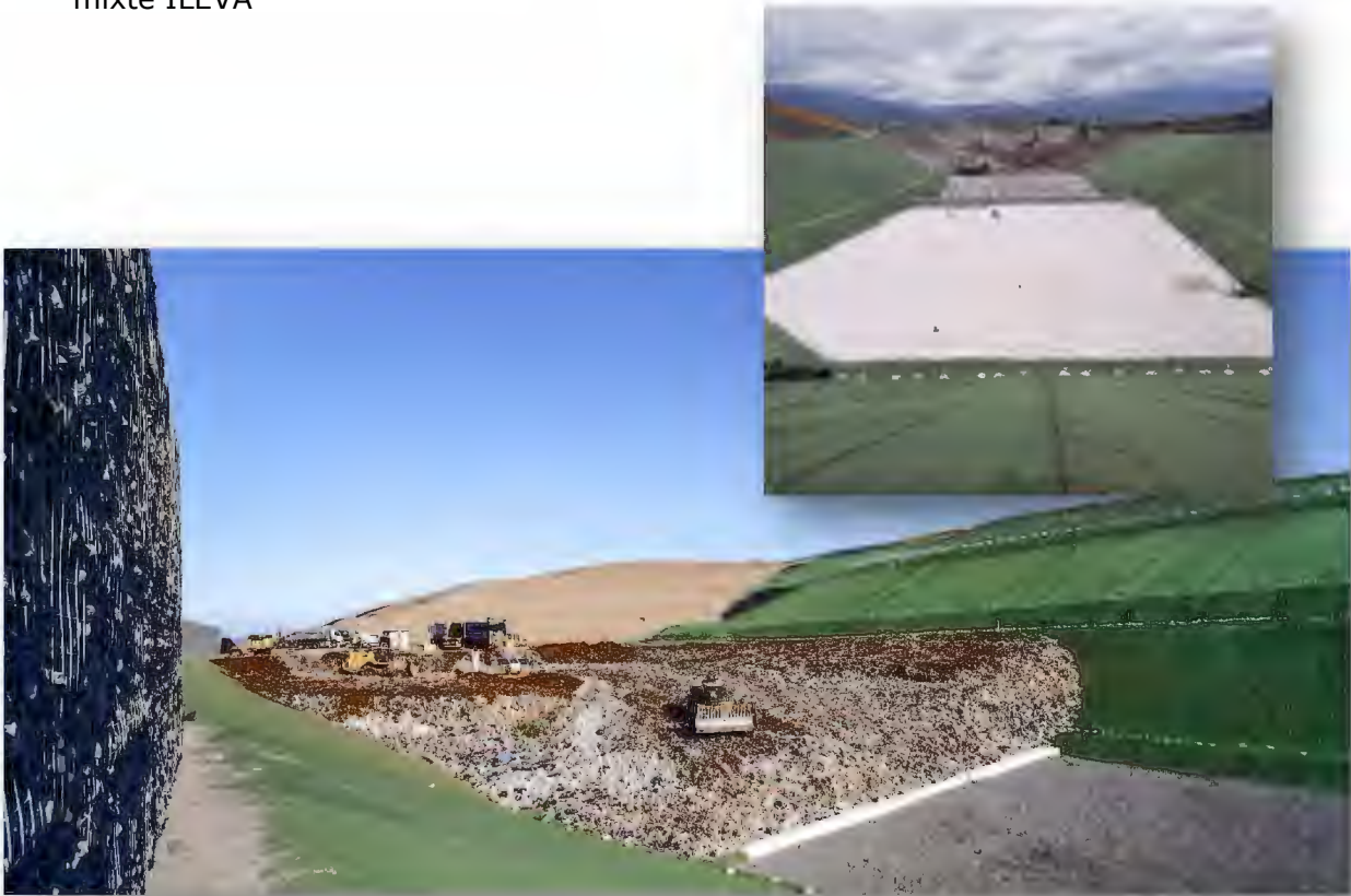
Photo 1 : Mise en exploitation de la tranche 7 le 08/03/2023.
